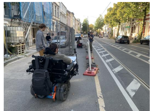
Abbildung 8: Nicht barrierefreie Baustellensicherung in Bonn (Fotos: Planungsbüro VIA)
