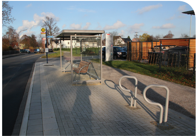
Abb. 12: Muster einer modernen und barrierefrei ausgebauten Haltestelle
